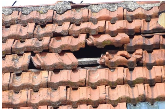
Abb. 20: Einflugmöglichkeiten am Dach durch Schäden der Dachhaut am Gebäude Kirchstraße 31.
