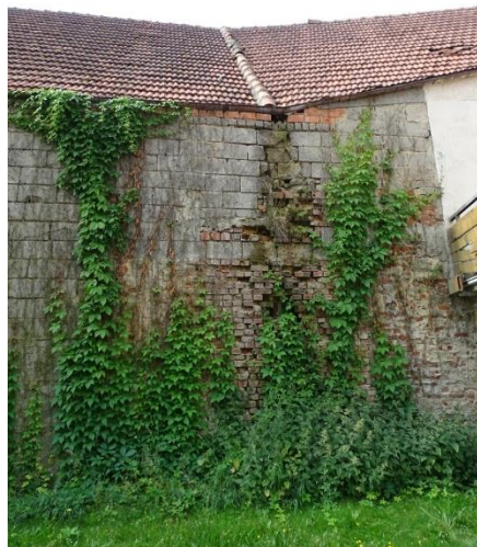
Abb. 28: Quartierpotenziale im Mauerwerk an Gebäude Kirchstraße 31.
