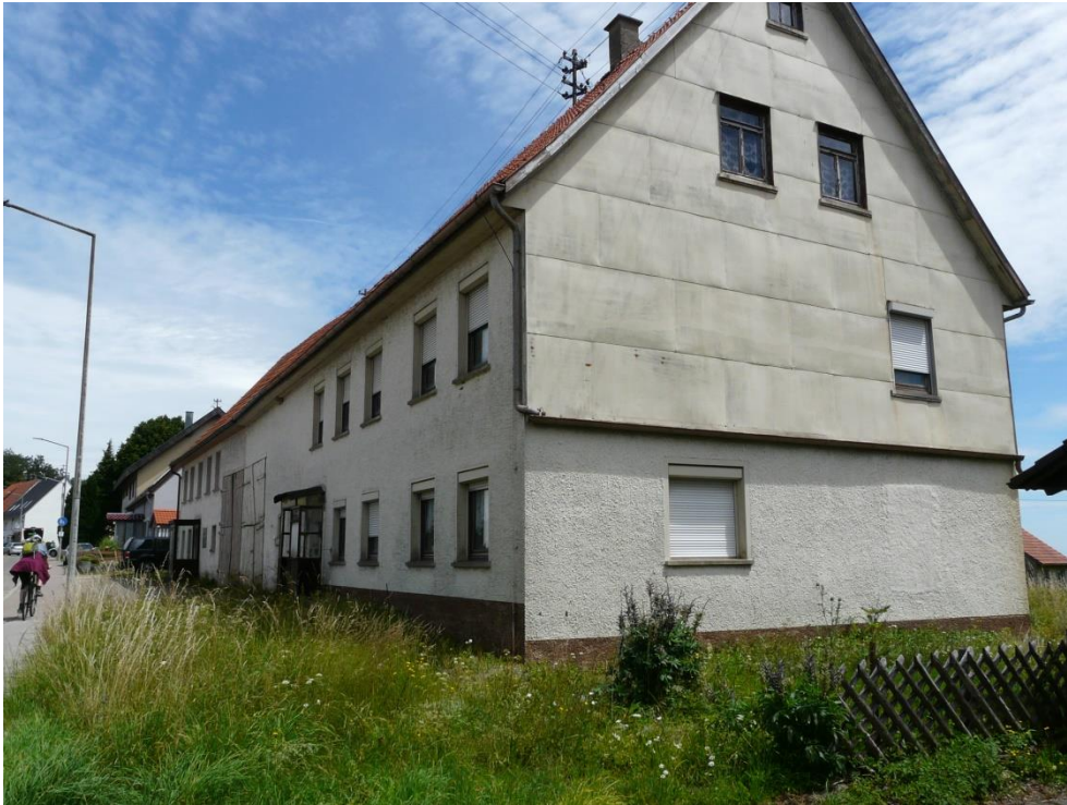
Abb. 7: Leerstehendes Gebäude Kirchstraße 29 – 31 mit verkleideter Fassade an der Südseite.
