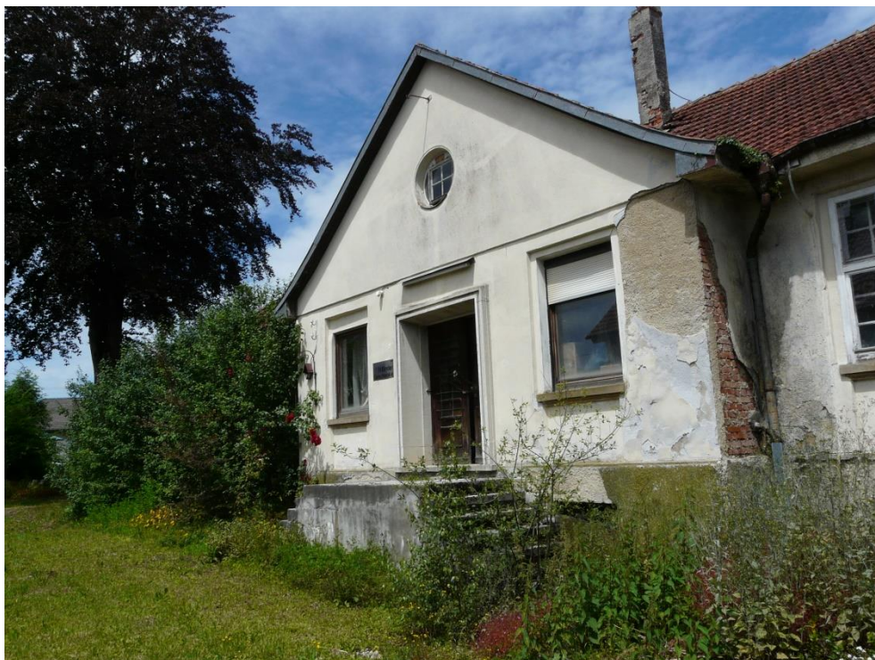
Abb. 6: Leerstehendes Fabrikgebäude Kirchstraße 37 (Flst. 1009/1). Südseite.
