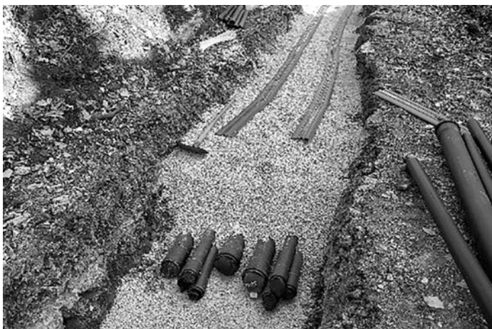
Leerrohrverlegung für Stromkabel und schnelles Internet im Bereich Roggental/Brunnensteige
