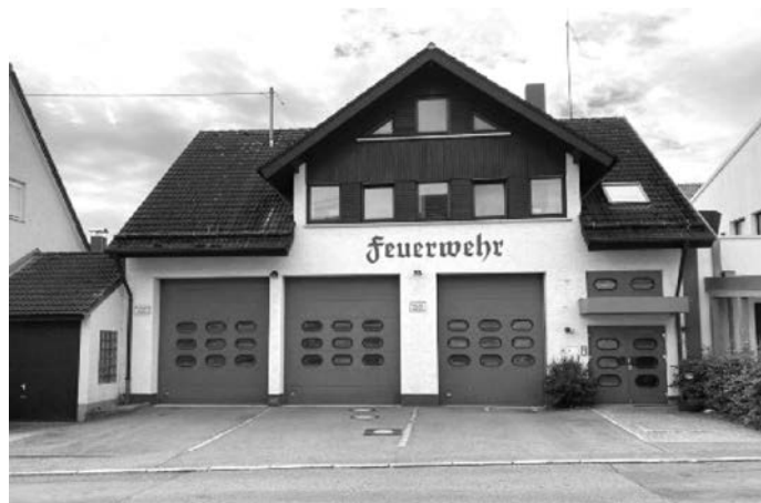
Foto: Altes Feuerwehrhaus
