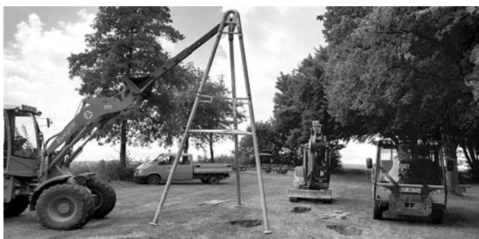
Der Fuhr- und Gerätepark des Bauhofs in vollem Einsatz
