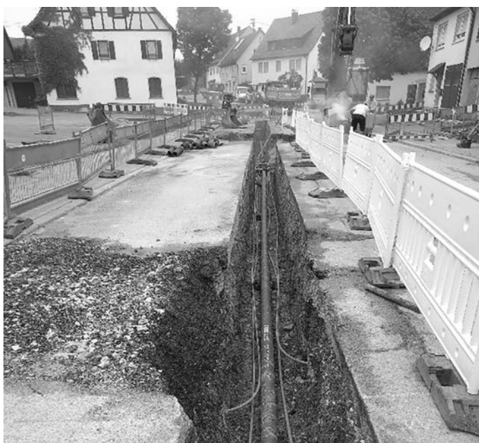
Die neue Leitung ist verlegt
