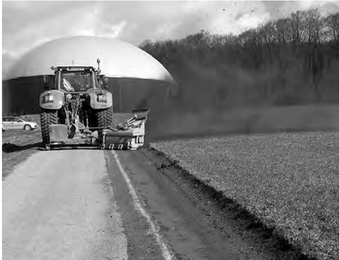
Feldwegsanierung zwischen Treffelhausen und Schnittlingen
