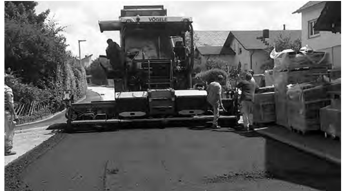
Die Böhmenkircher Straße erhält einen neuen Asphaltbelag
