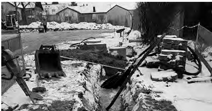
Vorarbeiten für den Kindergartencontainer am Hungerberg
