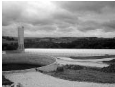
Biogasanlage mit Schlamm-trocknung im Folientunnel
